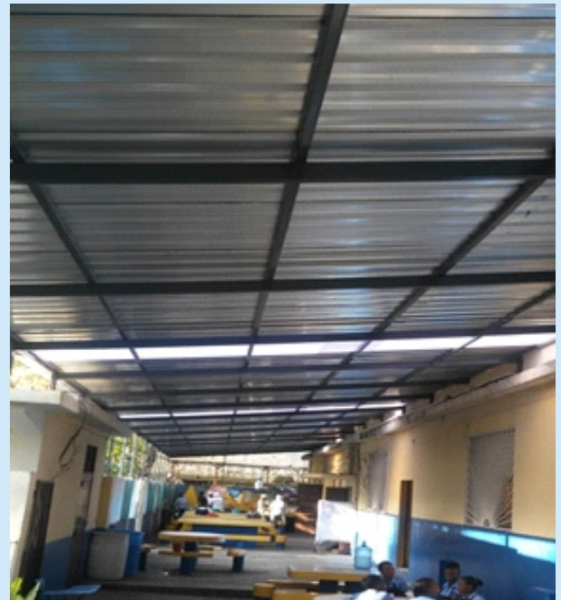
Installation nouvelle toiture
